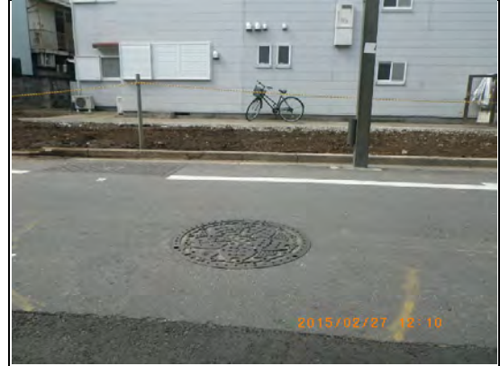
TBM(合流マンホール中心)
